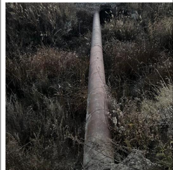
唐巴勒活塞干渠：渡槽
