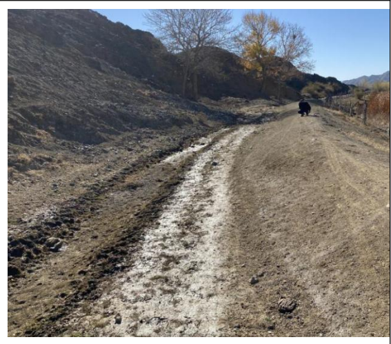
阿尕什敖包干渠：现状为土渠
