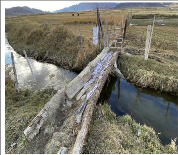
南山坡支渠：现状为土渠，简易桥
